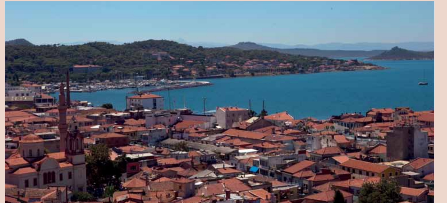
Eski fabrika bacaları ve kiliseleriyle Ayvalık
